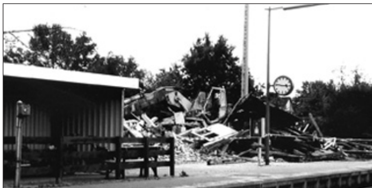
Die Abrissarbeiten 1990 waren eine Nacht- und Nebelaktion der DB
