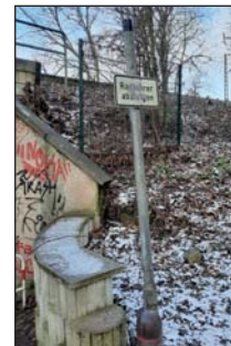
Lampenmast ohne Lampe
